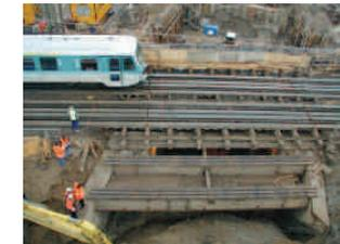
**Außer dem Einbau der Schwellenersatzträger und Kleinhilfsbrücken werden die Bauarbeiten außerhalb des Gleis- bzw. Gefahrenbereiches ausgeführt**
