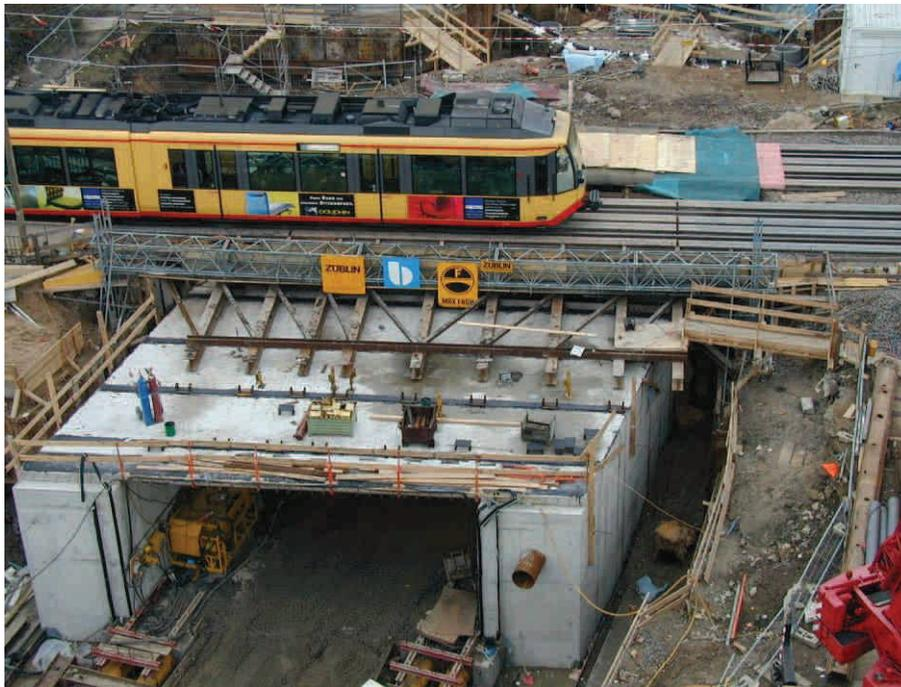
Sicherer Eisenbahnbetrieb während des laufenden Einpressvorganges
