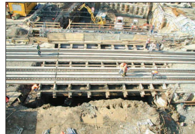
Für den sicheren Eisenbahnbetrieb sind technische Maßnahmen zur Baugrubensicherung (Verbauten) erforderlich
