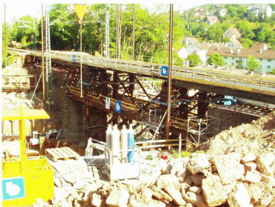
Abb. 1: Das Pilotprojekt 2006 „Safe Track Control“
